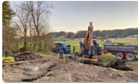
Oben: Erneuerung des Abwasserbehälters der Kleinkläranlage
